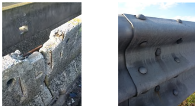
Figura 3 – Esempi di non integrità dei dispositivi di sicurezza
